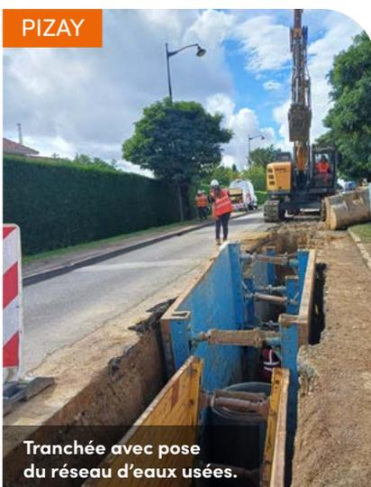
**Démarrés en mars 2025, les travaux de mise en séparatif du réseau d'assainissement se poursuivent à Pizay sous la maîtrise d'ouvrage de la 3CM.**
